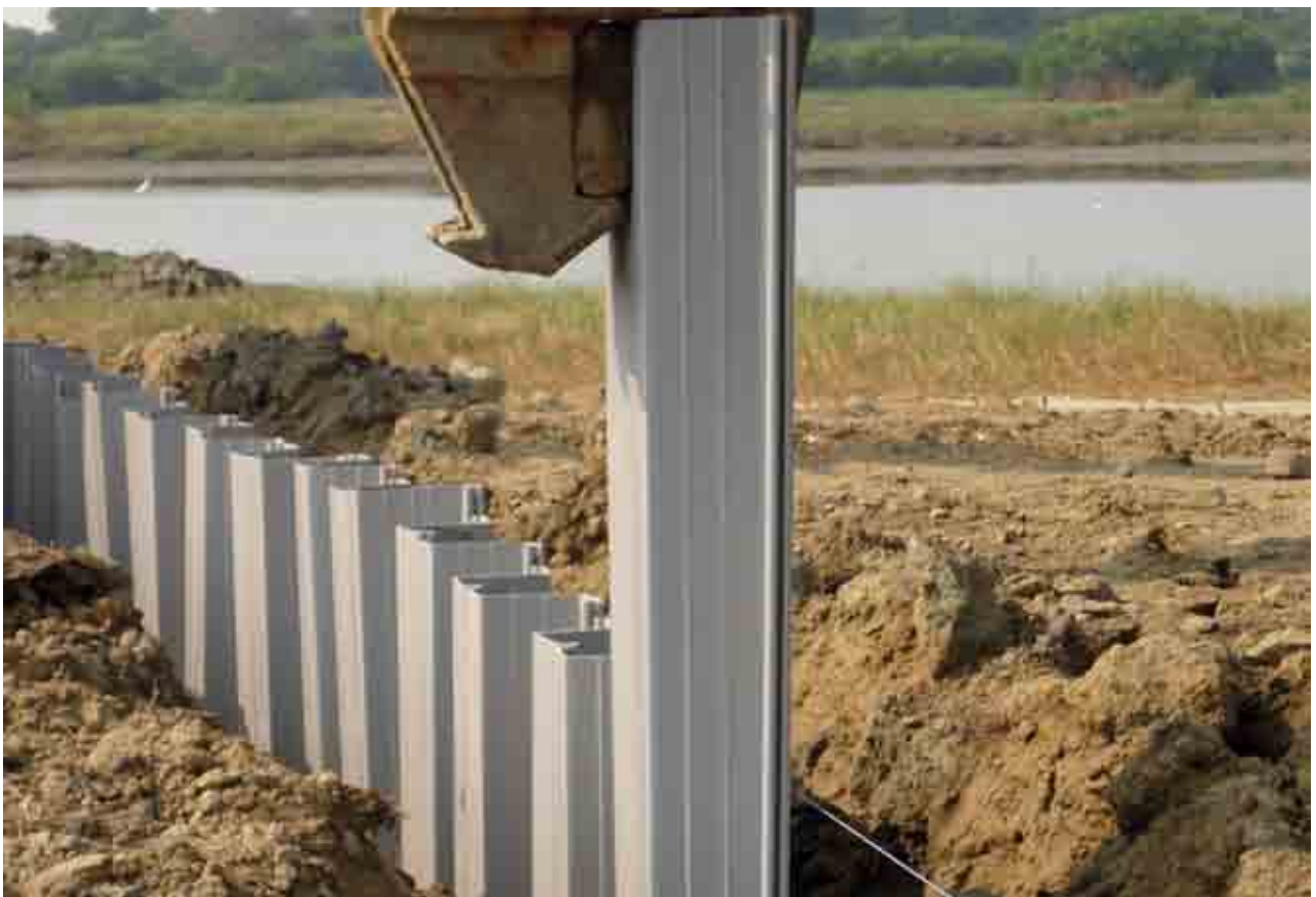
Riverside Construction 屏東放索溝整治工程
