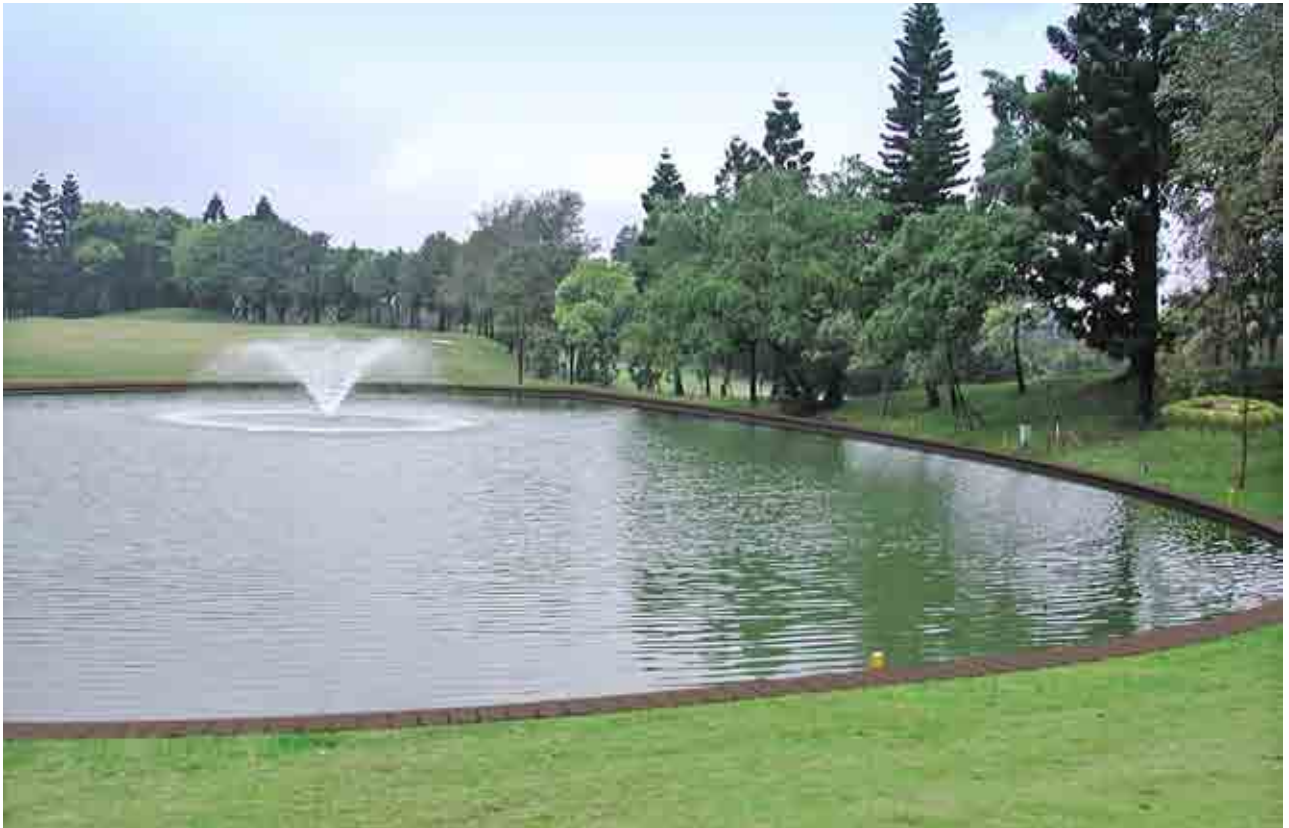
Golf Course Pond Construction 林口長庚球場水池工程
