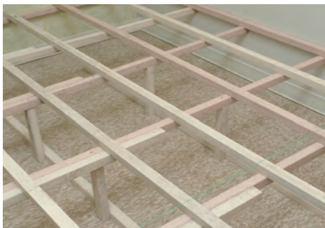
舒活角材施工情形 ECO angle bar implementation
